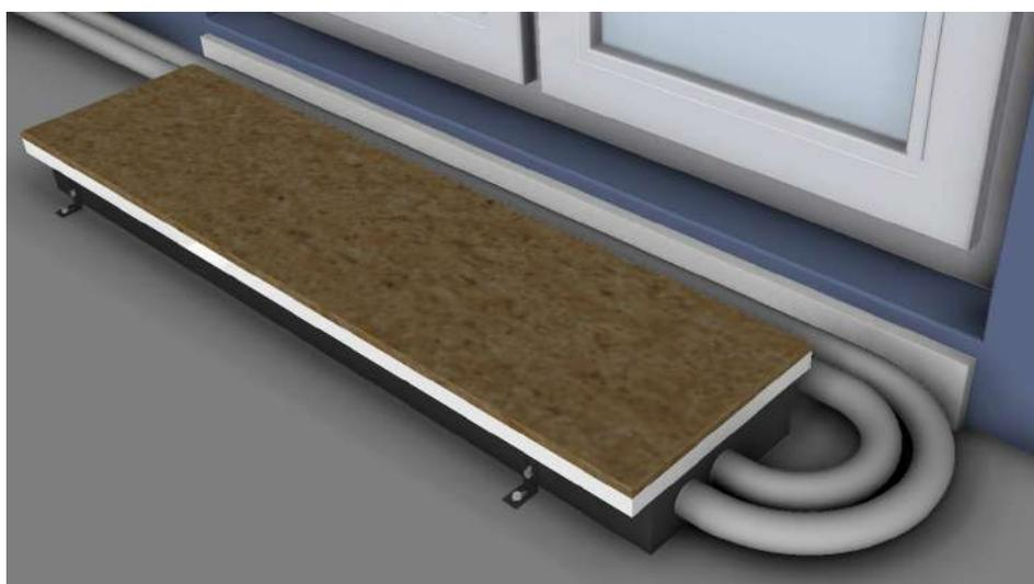
11. Залить бетоном зазоры между стенками отопительного канала и корпусом конвектора;
