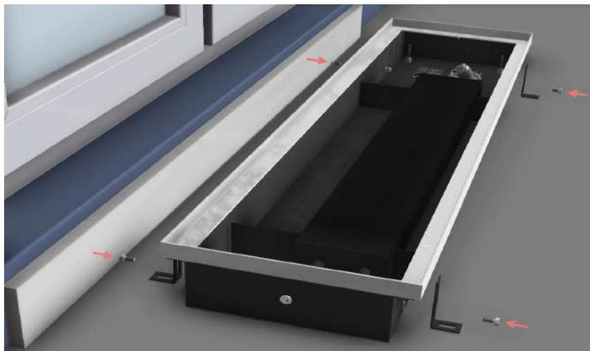
2. Установить конвектор в отопительный канал, после чего с помощью юстировочных винтов (поз. 6) выровнять корпус конвектора в горизонтальной плоскости с допуском  $\pm 1$  мм. При выравнивании конвектора необходимо учитывать, чтобы верхняя кромка декоративной рамки (или окантовки) (поз. 3), находилась заподлицо с напольным покрытием;
