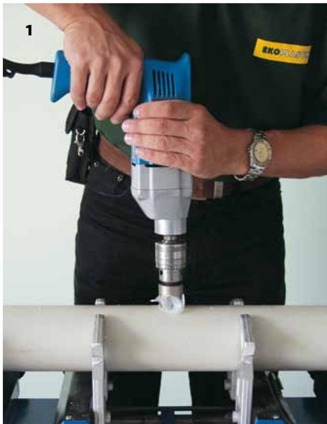
1 Специальной фрезой высверлить отверстие для седла
