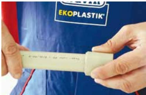
**10/** По окончании нагревания снимаем трубу и фитинг с насадки и соединяем их медленным, равномерным движением без осевого поворота, насадив трубу на фитинг на всю глубину до отметки.
