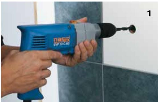
Просверленное отверстие рассверлить (откалибровать) сверлом 10 мм.
