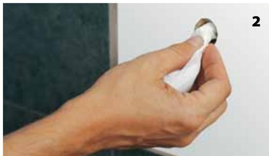
Высушить и обезжирить просверленное отверстие. На ремонтном стержне отметить расстояние, равное толщине стенки просверленной трубы + 2 мм (глубина ввода), на штыре насадки установить кольцевую отметку на расстоянии, равном толщине стенки просверленной трубы.
