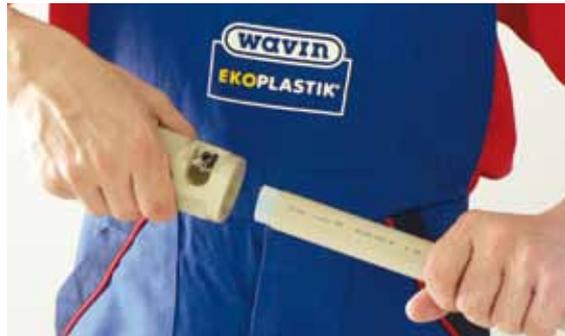
6/ Рекомендуется дополнительно обозначить место соединения на трубе и на фитинге для того, чтобы избежать поворота свариваемой трубы относительно фитинга. Для этой цели можно использовать монтажные отметки на фитингах.
