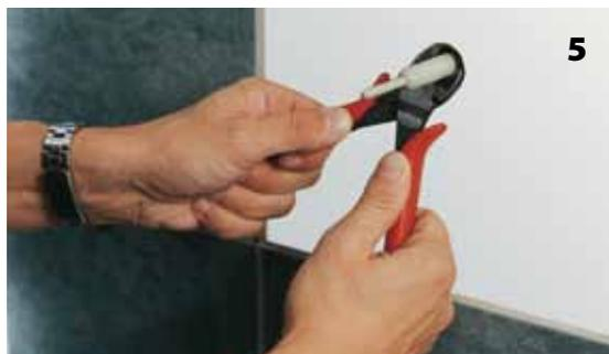
После охлаждения лишнюю часть стержня обрезать ножницами.
