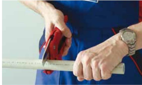
Ekoplastik Stabi работаем так же, как и с цельнопластиковой трубой Ekoplastik PPR.
